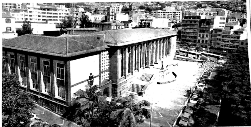
Construído em 1956 e actualmente em fase de remodelação, o Palácio da Justiça está no 'coração' da cidade.
